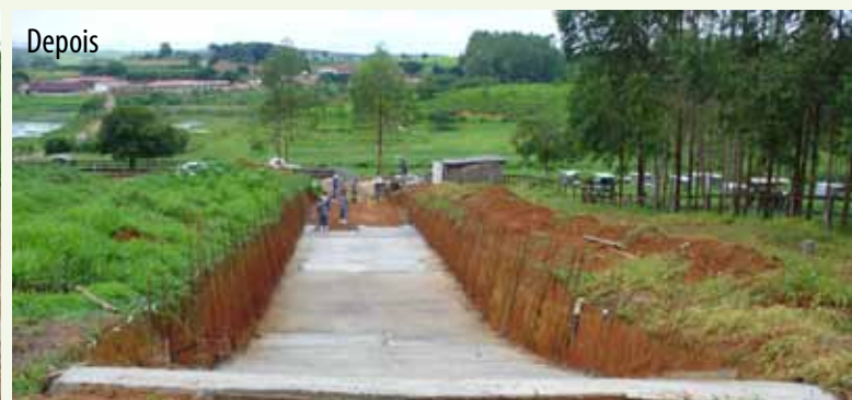
Silo em concreto para silagem (próximo à Suinocultura)
