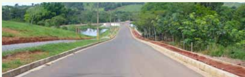
Drenagem e asfaltamento da entrada do Campus
